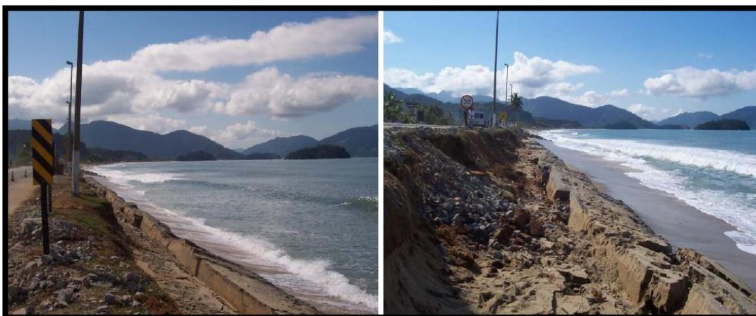
Figura 6 – Avarias do muro de contenção em junho de 2006. Fonte: Ceccarelli (2009).
