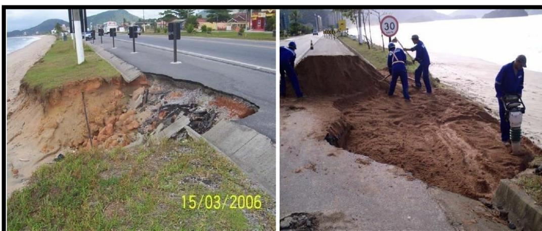
Figura 5 – Processo de erosão na praia de Massaguaçu e início das obras de contenção.
