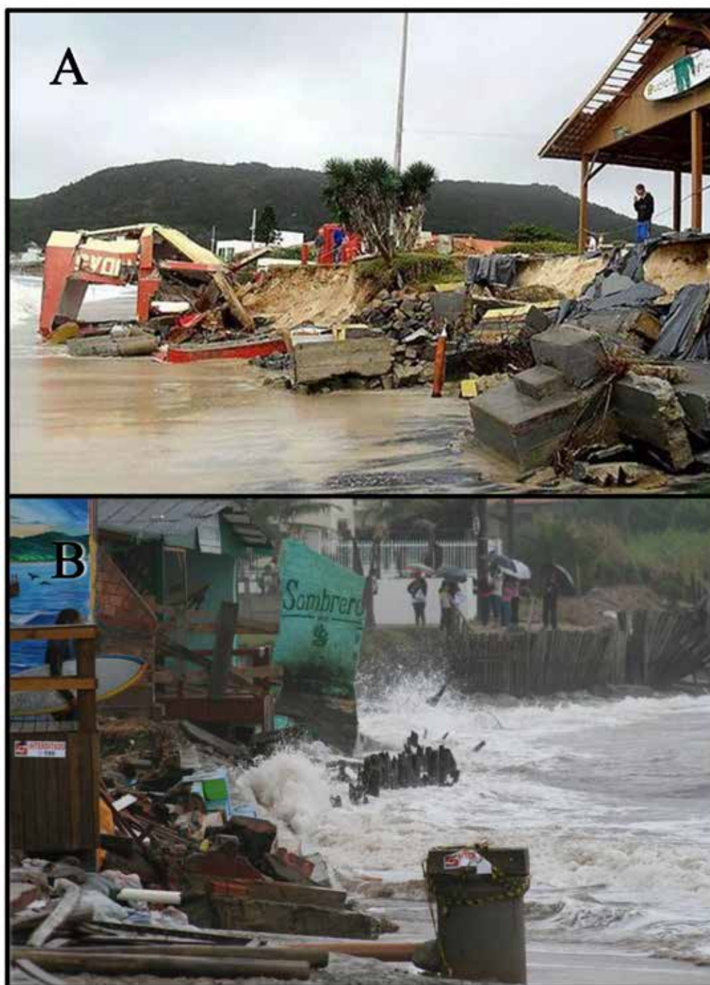
Figura 105: Efeito da ressaca que atingiu a Praia da Barra da Lagoa em maio de 2010. Bares, casas e estruturas públicas foram danificados. (Fotografias: (A) Cesar Carvalho e (B) Disponível em: < https://escandiuzzi.wordpress.com >
